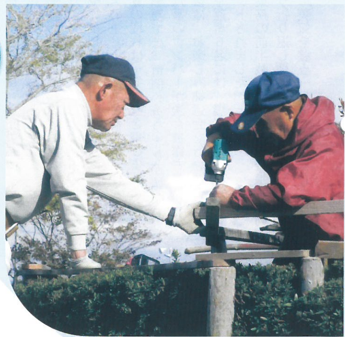
▲11月5日(月)から9日(金)まで、みかわ保育園、横山・東郷・押切小学校、三川中学校の雪囲い作業を行いました。天候にも恵まれ、すべての作業は順調に進みました。
